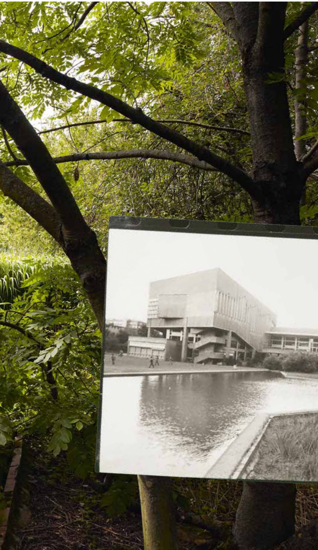
Das Hörsaalgebäude von der Südseite aus gesehen. Heute dominieren Pflanzen das Bild.
